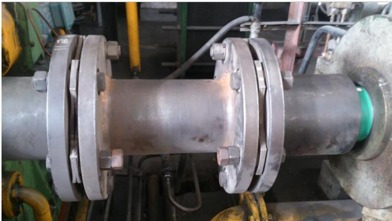
图五，给水泵与液力偶合器之间的联轴节
